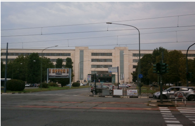
Prospetto principale su corso Agnelli (fonte: foto Roberta Oddi 28/07/2020)
