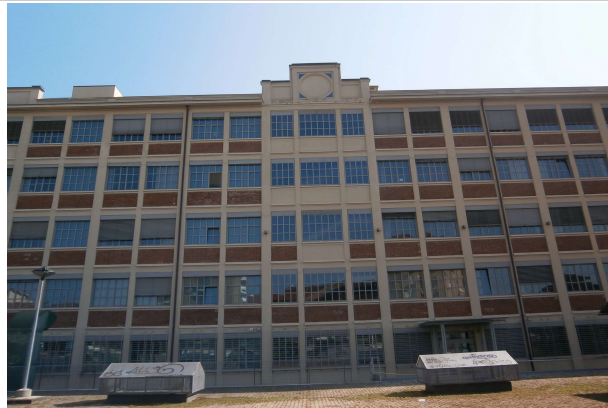
Veduta da piazzale su corso Racconigi (fonte: foto Roberta Oddi 30/09/2020)
