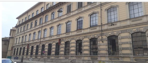
Prospetto su via San Donato (fonte: foto Roberta Oddi 21/07/2020)
