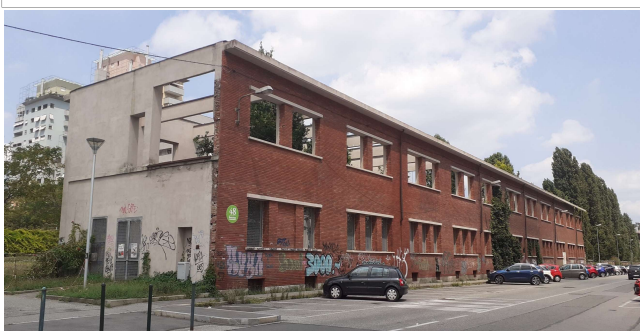
Edificio del nucleo originario su via Nole (fonte: foto Roberta Oddi 21/07/2020)
