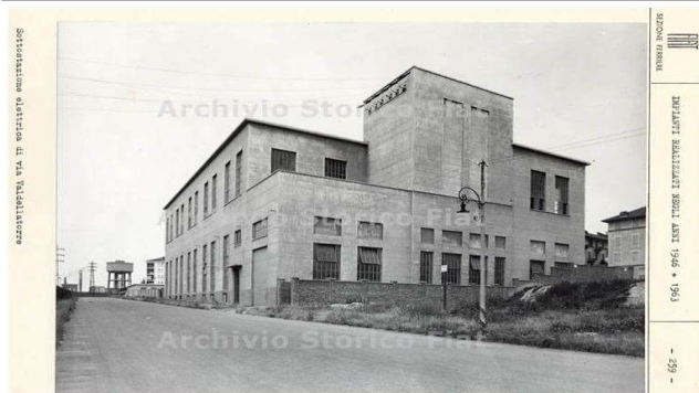
Immagine d'archivio della sottostazione elettrica di via Valbellatorre. Fotografia Archivio Storico Fiat, Sezione Ferriere, Impianti realizzati nel 1946 e 1963 (fonte: www.museotorino.it )
