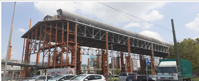
Veduta della struttura esistente da corso Mortara (fonte: foto Roberta Oddi 21/07/2020)
