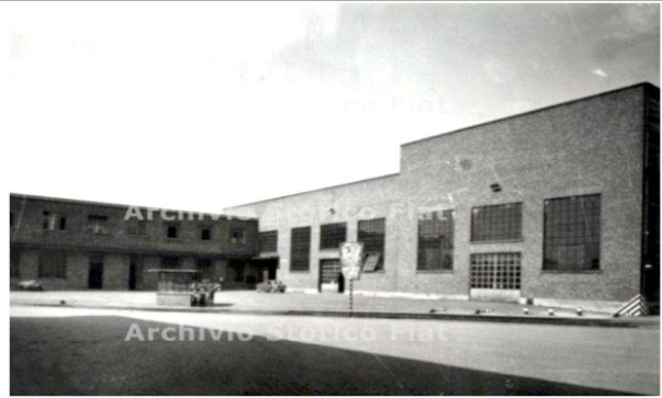
Officina elettrica principale nel secondo dopoguerra, Archivio Storico FIAT, Fondo Ugaf, 4/13, Fiat sezione ferriere. Impianti realizzati negli anni 1946-1963, vol. I. (fonte: www.museotorino.it )
