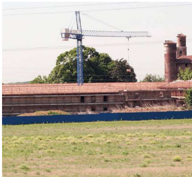
Riqualificazione delle cascine storiche: lavori in corso per le Residenze Parco Castello del Drosso. (Fonte: L.Davico 2015.)
