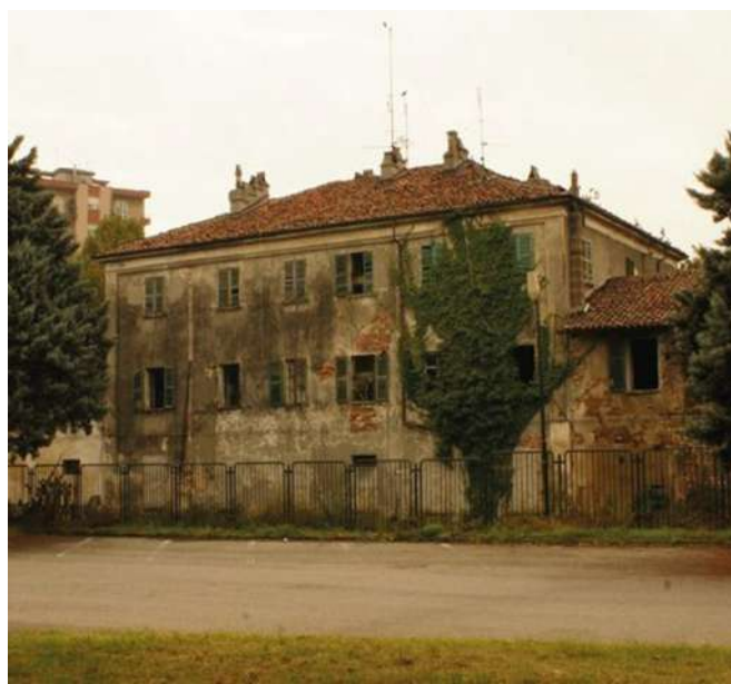
Veduta laterale della cascina ripresa dal parco pertinenziale dell'edificio scolastico di istruzione secondaria superiore. Cascina Nuova di corso Unione Sovietica. (Fonte: E.Vigo 2012.)
