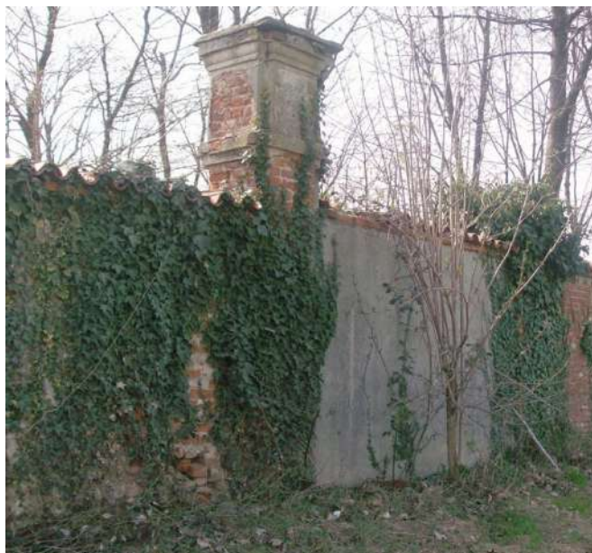
Portale di accesso alla cascina Perino del Drosso. (Fonte: I.Zappavigna 2009.)
