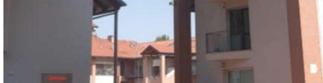
Veduta dell'ingresso principale della cascina ripresa da Corso Unione Sovietica. (Fonte: C.Devoti e G.Bronzino 2020.)
