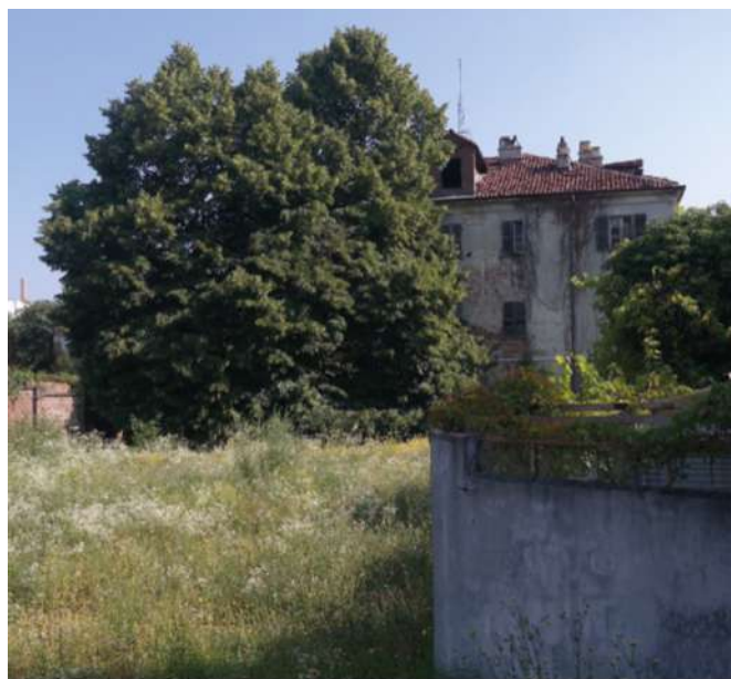
Veduta della cascina frontale con relativa corte interna pertinenziale. (Fonte: C.Devoti e G.Bronzino 2020.)
