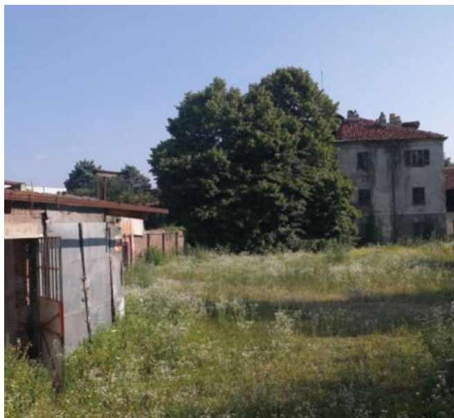
Veduta della cascina frontale con relativa corte interna pertinenziale; si intravede anche la presenza del muro di cinta perimetrale. (Fonte: C.Devoti e G.Bronzino 2020.)
