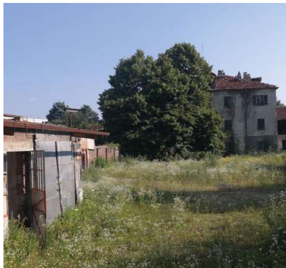
Veduta della cascina frontale con relativa corte interna pertinenziale; si intravede anche la presenza del muro di cinta perimetrale. (Fonte: C.Devoti e G.Bronzino 2020.)
