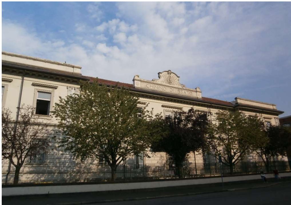
fig. 31 – Stabilimento ex fabbrica Chinino di Stato (fonte: foto Roberta Oddi 28/07/2020)
